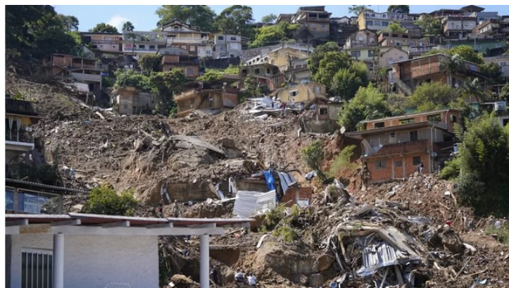
Rastro da devastação causada pela chuva no Morro da Oficina, no Alto da Serra, em Petrópolis — Foto: Marcos Serra Lima/g1
